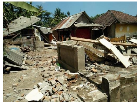
西ロンボクケカイト村で倒壊した建物
